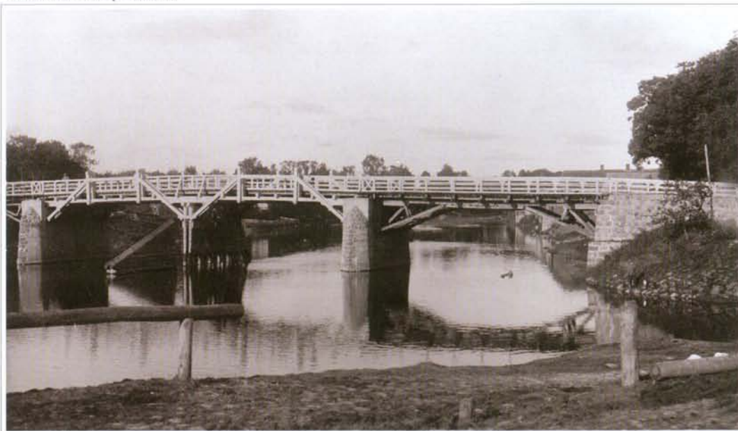
Medinis tiltas ant akmens mūro atramų per Lēvens upę Pasvalyje 1940 m. iš aukštupio pusės.
