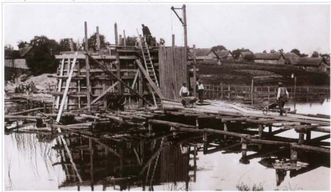
Betonas į atramą vežamas karučiais laikinuoju tiltu ir užkeliamas rankine gerve.
