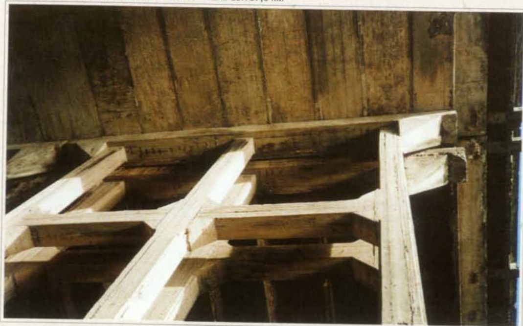
Šeštos atramos kolonų ir skersinių ryšių vaizdas.
