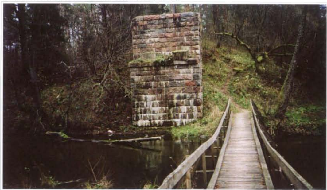
Geležinkelio tilto, statyto 1899 m. per Varėnės upę, kairiosios krantinės atramos likučiai 2001 m.
