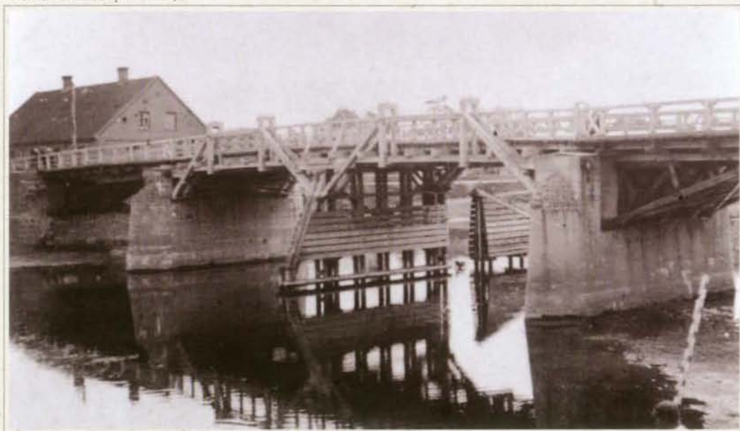
Medinis tiltas ant akmens mūro atramū per Lēvens upē Pasvalyje 1940 m. iš žemupio pusės.
