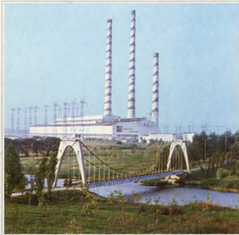
Kabantis pėsčiųjų tiltas Elektrėnų šiluminėje elektrinėje.
