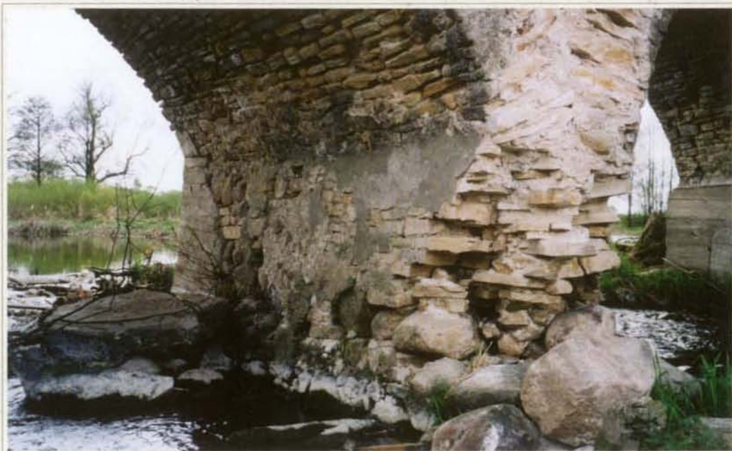
Grūvanti romėnų pavyzdžio dolomitinė arka ir atrama 1999 m.
