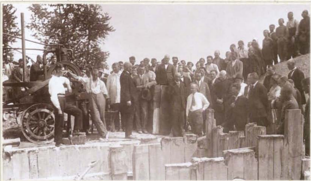
Pirmojo kubo betono maišymas garine betono maišykle ir liejimas krantinėje atramoje.
