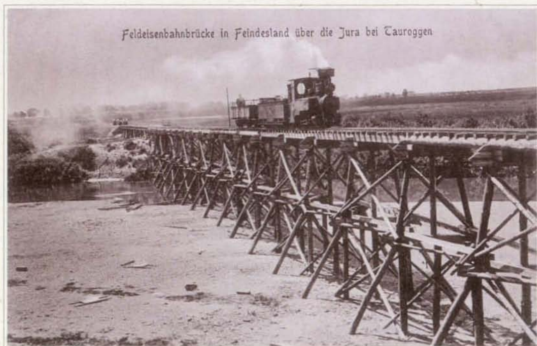
Laikinas medinis geležinkelio tiltas per Jūros upę prie Tauragės. Tiltą prieš I pasaulinį karą pastatė vokiečių kariuomenė. „Siaurojo geležinkelio tiltas į priešų šalį per Jūros upę prie Tauragės“, — taip parašyta ant šio atviruko, leisto Tilžėje 1915 m.
