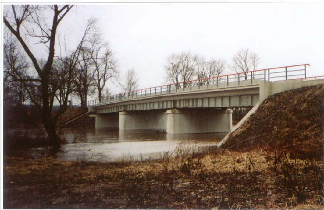
Metalinis tiltas per Jūros upę kelio Kaunas—Jurbarkas—Šilutė—Klaipėda 126,72 km pastatytas 1952 m. Tiltas trijų tarpatramių, 62,80 m ilgio.
