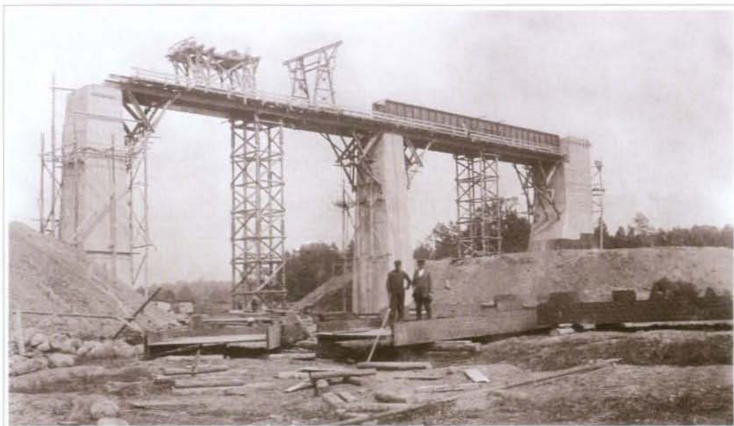
Geležinkelio tilto statyba per Salanto slėnį netoli Kūlupėnų, Kretingos—Telšių geležinkelio linijoje.
