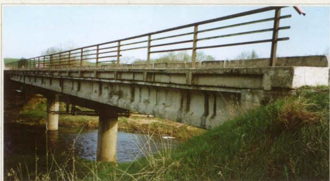
Tiltas pastatytas 1962 m. Tai trijų tarpatramių, karpytos sistemos tiltas. Tarpatramiai perdengti 22,16 m ilgio sudurtinėmis sijomis su diafragmomis. Skersiniame tilto pjūvyje — penkios sijos. Bendras perdangos ilgis - 66,6 m. Krantinės atramos pastatytos ant polinių pamatų. Tarpinės atramos — vienkulpės monolitinės kolonos.
