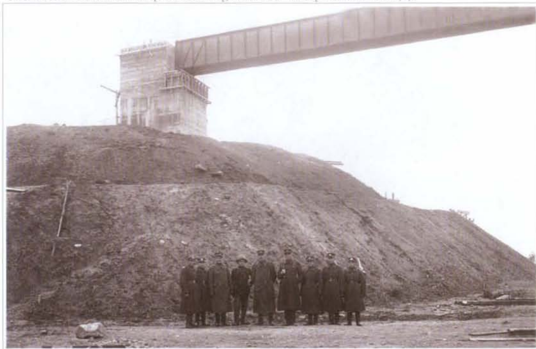
Metalinis 102 m ilgio ir 26 m aukščio tiltas pastatytas 1930—1931 m. Klaipėdos susisiekimą pagerino nepriklausomybės metais nutiestos Žemaičių geležinkelio ir plento linijos, sujungusios Klaipėdą su kitais Lietuvos centrais.
