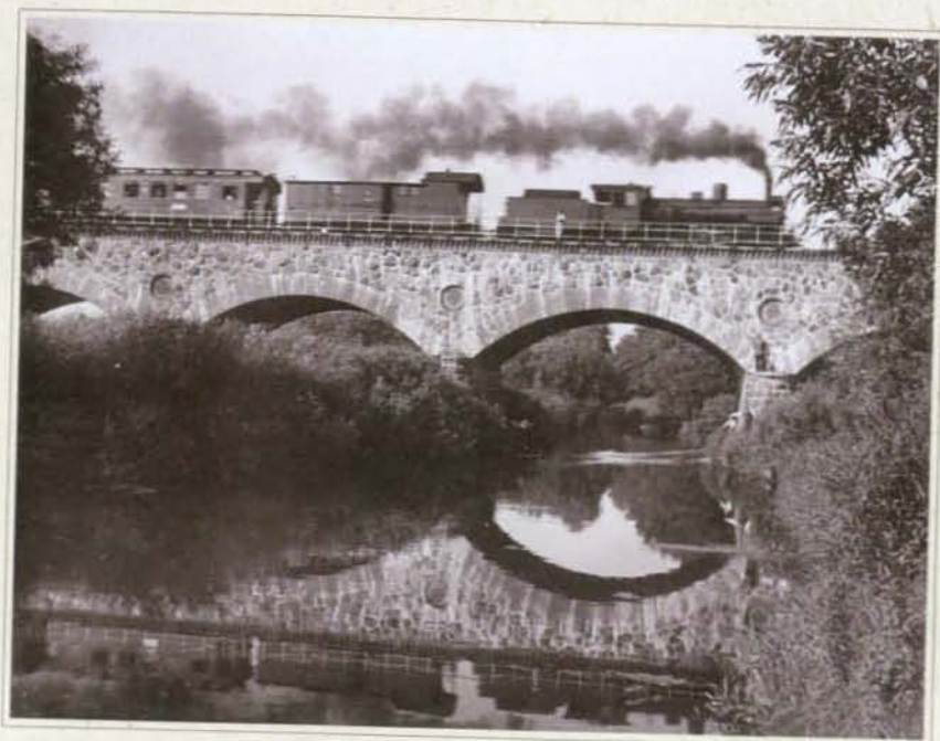
Statant Tilžės—Klaipėdos geležinkelį, 1872—1875 metais buvo pastatytas akmens mūro arkinis tiltas per Miniją. The quarry-stone masonry arch bridge across the Minija River was built in 1872-1875 on the railway Tilžė-Klaipėda.
