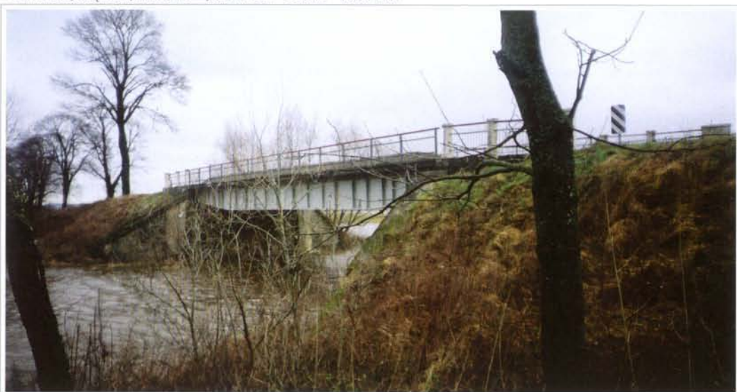
Metalinis tiltas per Jūros upę kelio Kaunas—Jurbarkas—Šilutė—Klaipėda 126,90 km pastatytas 1952 m. Tiltas vieno tarpatramio, 26,50 m ilgio.
