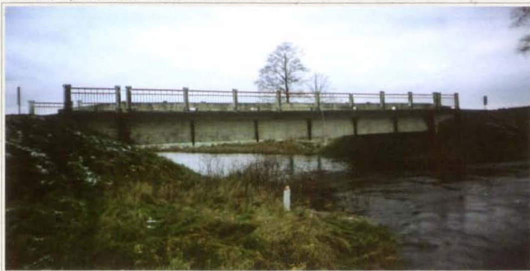
Metalinis tiltas per Jūros upę kelio Kaunas—Jurbarkas—Šilutė—Klaipėda 127,42 km pastatytas 1954 m. Tiltas vieno tarpatramio, 20,80 m ilgio.
