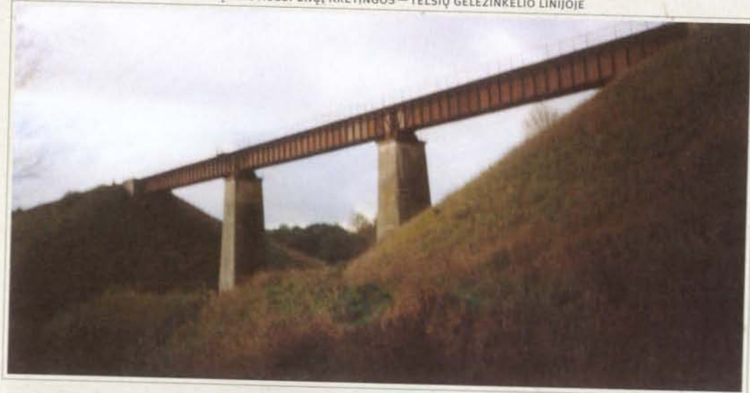
Geležinkelio tiltas per Salantą slėnį netoli Kūlpėnų, Kretingos—Telšių geležinkelio linijoje 1999 m.
