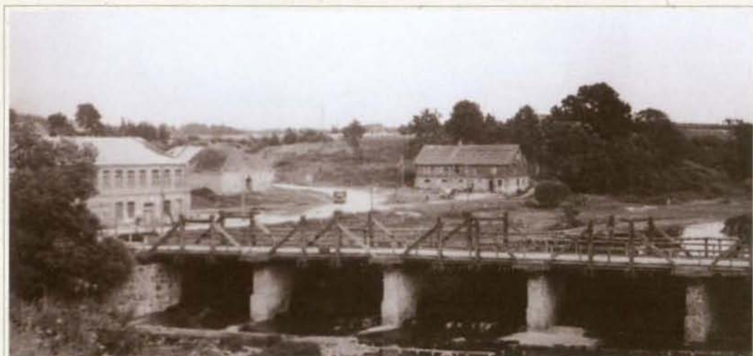
Medinis tiltas per Virvyčią ties Kapėnais. Krantinės ir tarpinės atramos akmens mūro.
