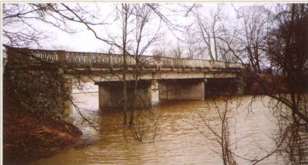
Gelžbetoninis tiltas per Jūros prataką kelio Kaunas—Jurbarkas—Šilutė—Klaipėda 127,42 km pastatytas 1966 m. Tiltas trijų tarpatramių, 49,50 m ilgio.
