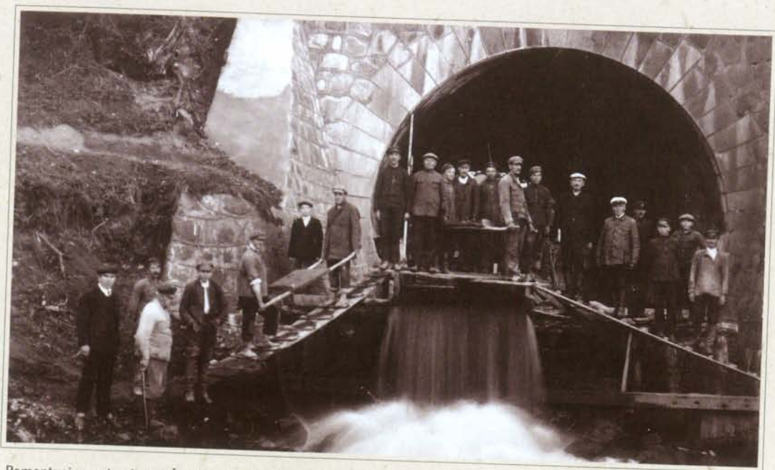
Remontuojama dauda per Šešuvos upę Turžėnuose, kelyje Kaunas—Zarasai 1926 m..
