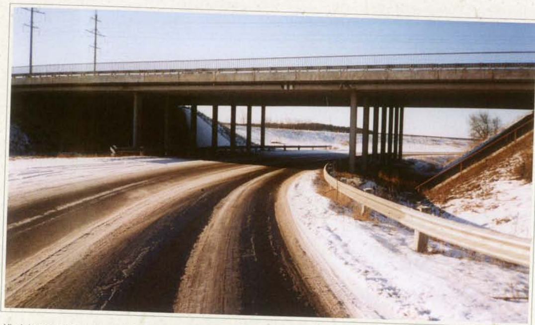
Viadukas nuvažiavimui nuo Č. Radzinausko tilto į Lampėdžius Kaune. Viaduką statė UAB „Kauno tiltai“.
