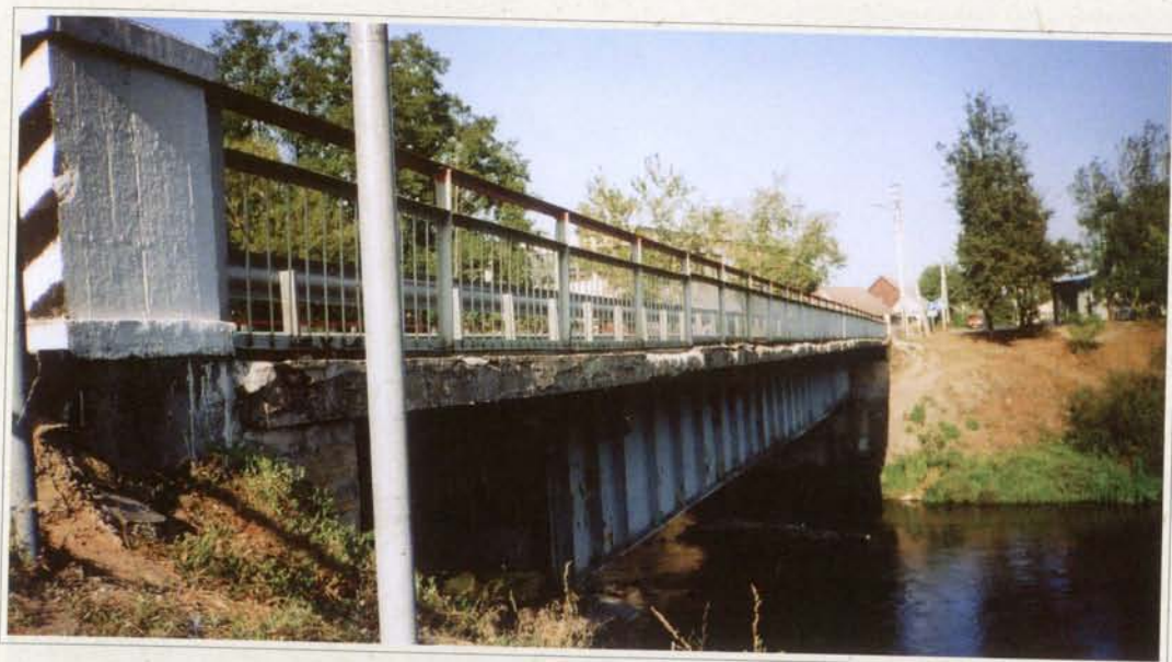
Metalinis tiltas per Žeimeną pastatytas 1959 m. Trijų tarpatramių tilto ilgis 61,74 m.
