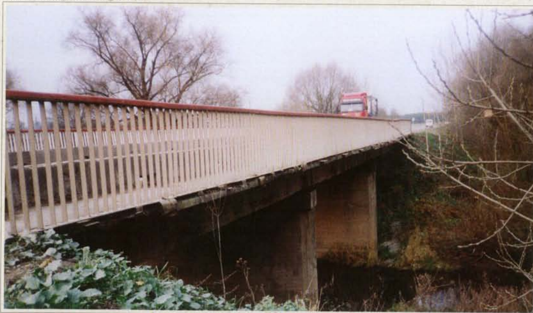
Gelžbetoninis, sijinis, karpytasis tiltas per Obelės upę Kėdainiuose pastatytas 1963 m. Atitvarai — gelžbetoniniai, 0,5 m aukščio. Turėklai — metaliniai, 1 m aukščio. Šaliteljiai — du, po 1,10 m pločio. Tiltas yra trijų tarpatramių, 42,26 m ilgio. Tarpinės atramos „sienutės“ tipo.
