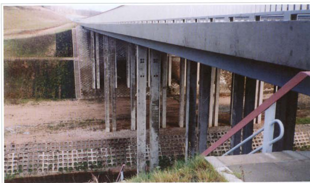
Rekonstruojant kelią Kaunas—Zarasai—Daugpilis, 1996 m. pastatytas tiltas per Šešuvos upę. Gelžbetoninis, rėminis, keturių tarpatramių, ant liaunų polinių atramų, 94 m ilgio tiltas. Kiekvienai kelio juostai pastatytas atskiras tiltas.
