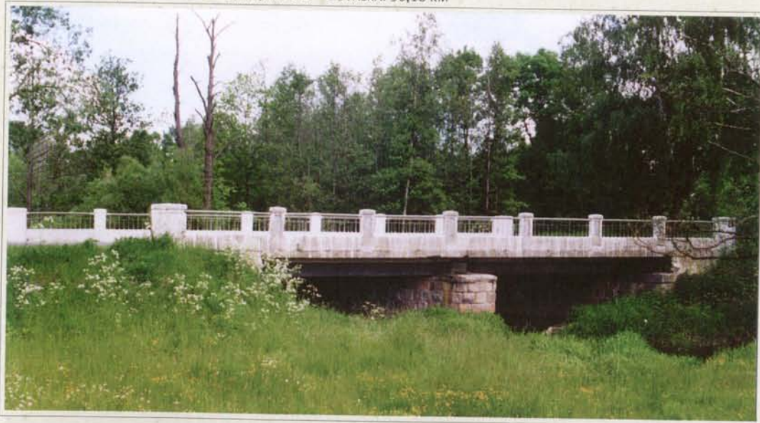
Tiltas dviejų tarpatramių (7,5+7,5), 21,50 m ilgio. Tarpatramio perdanga — metalinės sijos su monolitine, gelžbetonine plokšte. Ramtai ir taurai iš tašytų akmenų.
