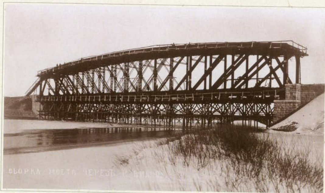
Petro Vileišio statomas plieninis geležinkelio tiltas per Viliją geležinkelyje Polockas—Siedlecas 1903—1905 m.
