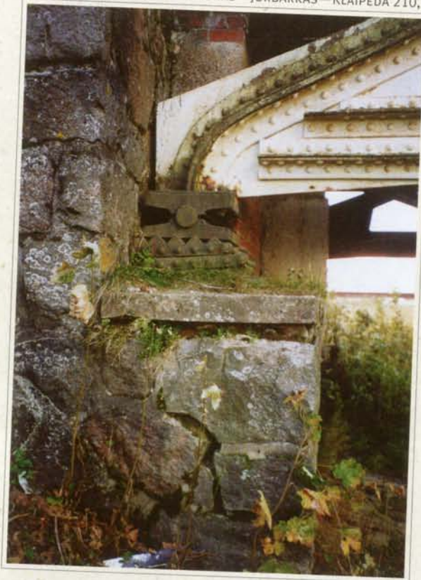
Slankiosios atramos vaizdas iš aukščiau pusės 1999 m. Ramtai — atviro tipo, masyvūs, akmens mūro. Ramtų atkaltės iš plytų mūro.
