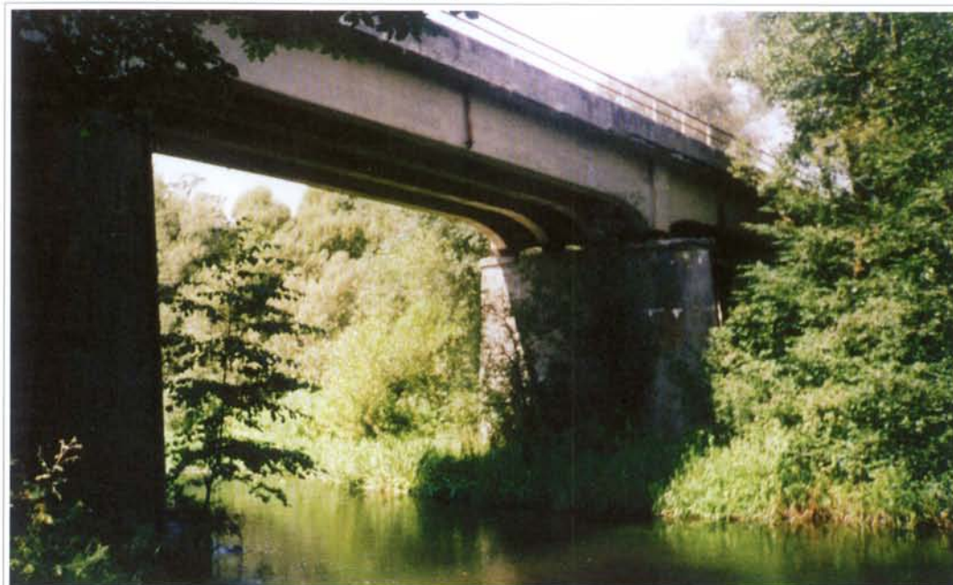
TILTAS PER STRĖVĄ KELIO RUMŠIŠKĖS—TADARAVA 9,7 KM
