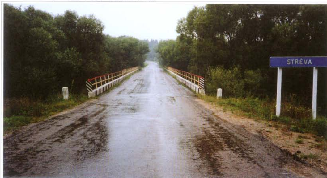
TILTAS PER STRĖVĄ KELIO RUMŠIŠKĖS—TADARAVA 9,7 KM
