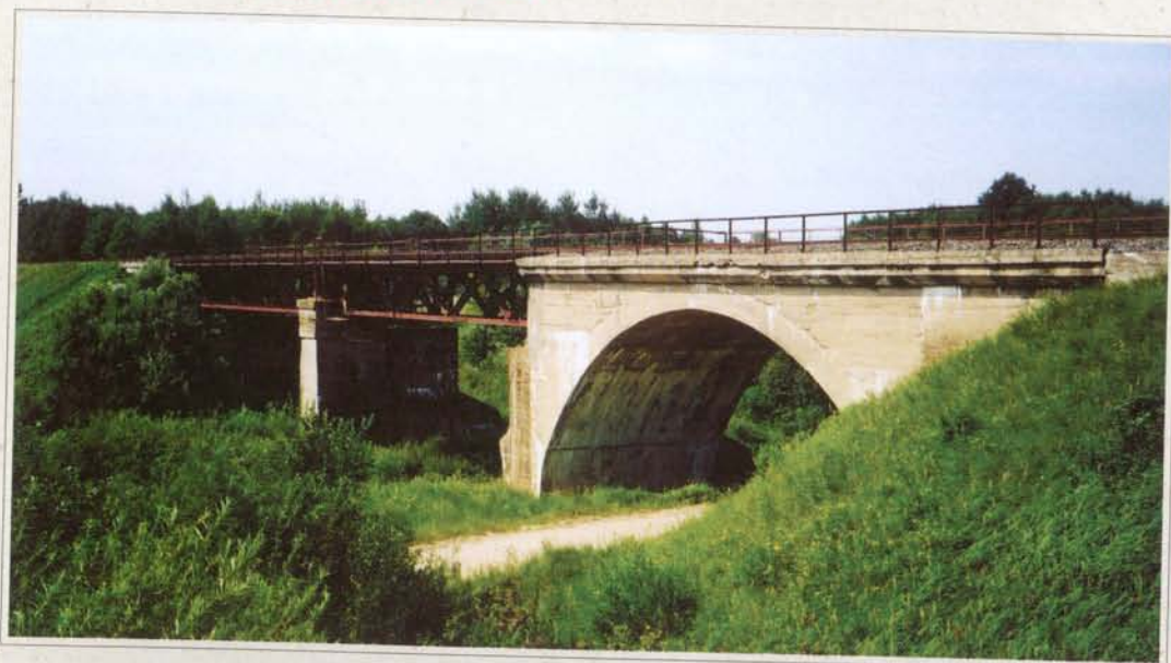
Tilto pirmasis tarpatramis pastatytas 1917 m., antrasis ir trečiasis — 1962 m. Originalus išliko tik monolitinis skliautas, kuriuo perdengtas pirmasis tarpatramis. Kiti du pokario metais įrengti tarpatramiai perdengti plieninėmis santvaromis, kurios sumontuotos ant stačiakampio skerspjūvio masyvių taurų ir monolitinio atvirojo ramto. Paklotas su viena geležinkelio vėže įrengtas santvarų viršuje.
